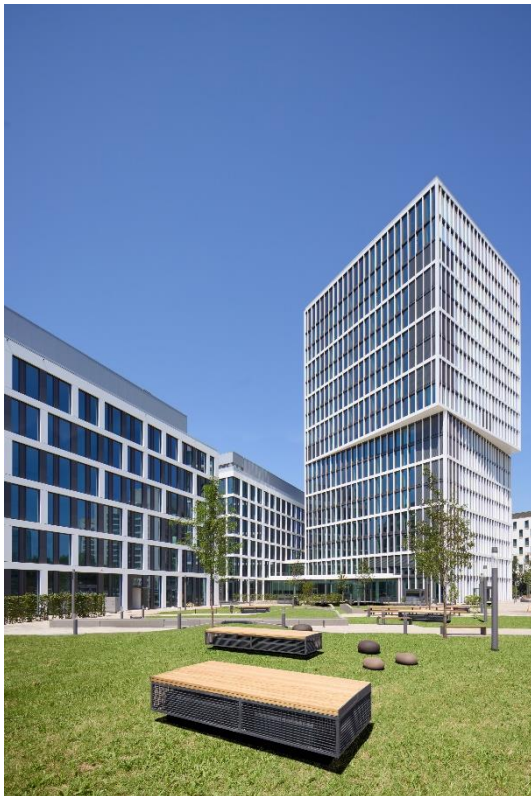
Gewerbequartier Eschborn Gate
