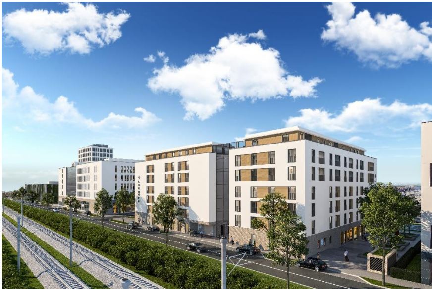
Instone Real Estate und BayernCare legten den Grundstein für Studentenapartments und Seniorenwohnungen im Quartier LOKHÖFE. (Foto: IMOAGENT)
